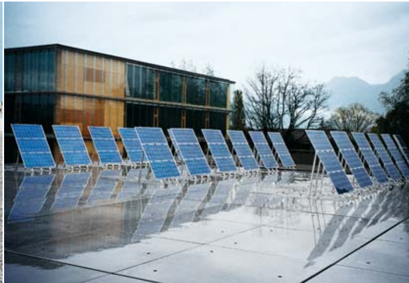
Fotos v.l.n.r.: KW-Solar, Mahler, Siblik Elektrik, Stromaufwärts
