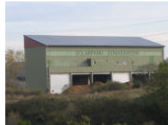
solare Ganzdachlösung bei einem Industriebau (ehemaliger Müllbunker mit Flachdach im Ursprungszustand)
