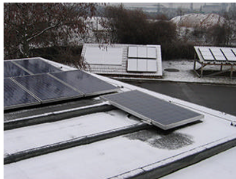
Das Solarfeld eine halbe Stunde später. Die unbestromten Modulfelder im Hintergrund waren trotz stärkerer Neigung nach wie vor schneebedeckt.
