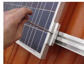
Bild: Modulklemmung
