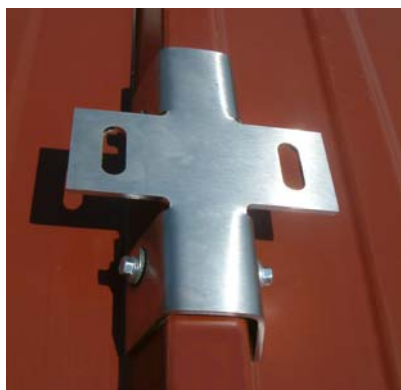
Schelle fertig gesetzt
