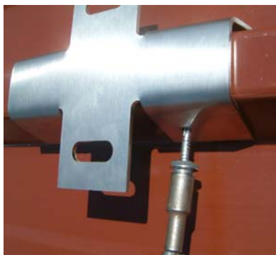
2. Schritt Verschrauben mit selbstbohrenden Schrauben
