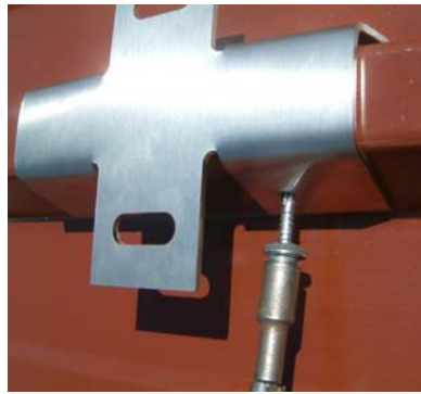
2. Schritt Verschrauben mit selbstbohrenden Schrauben
