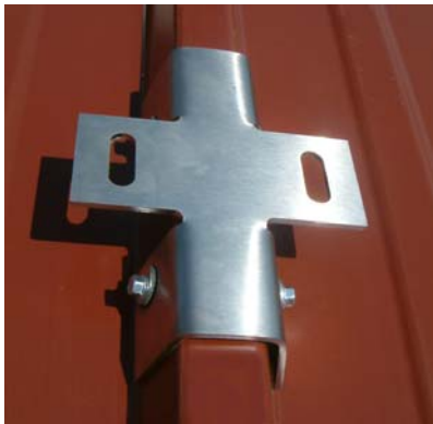
Schelle fertig gesetzt
