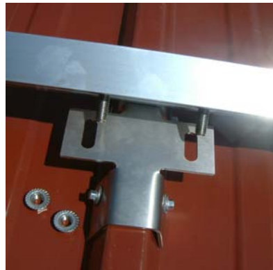
3. Schritt Querträger aufsetzen Zur besseren Kraftverteilung 2 Schrauben M10 verwenden!
